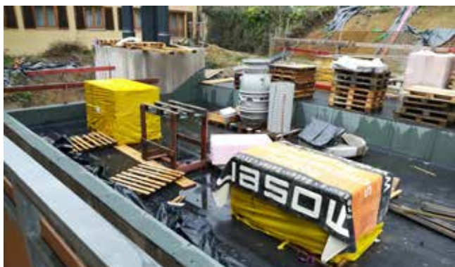
Dach der Heizzentrale (noch) als Lagerplatz
